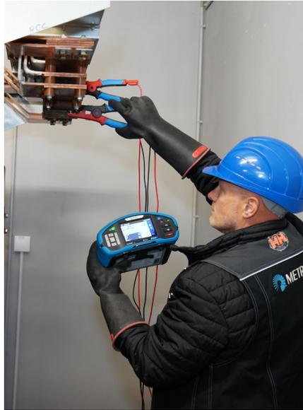
Regelmäßige Inspektionen der Z Line und Z Loop Impedanzen können schlechte Kontakte auf Sammelschienen, den Zustand von Leistungsschaltern, Schützen oder Sicherungshaltern zeigen. Es muss jedoch im hochauflösenden mili-Ohm-Bereich arbeiten. Die Genauigkeit des Ergebnisses hängt von der 4-Leiter-Verbindung und dem ausreichend hohen Prüfstrom ab.
