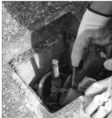
Der Megger DET14C zeigte die Messung eines Erdstabes in einem typischen Erdungsschacht.
