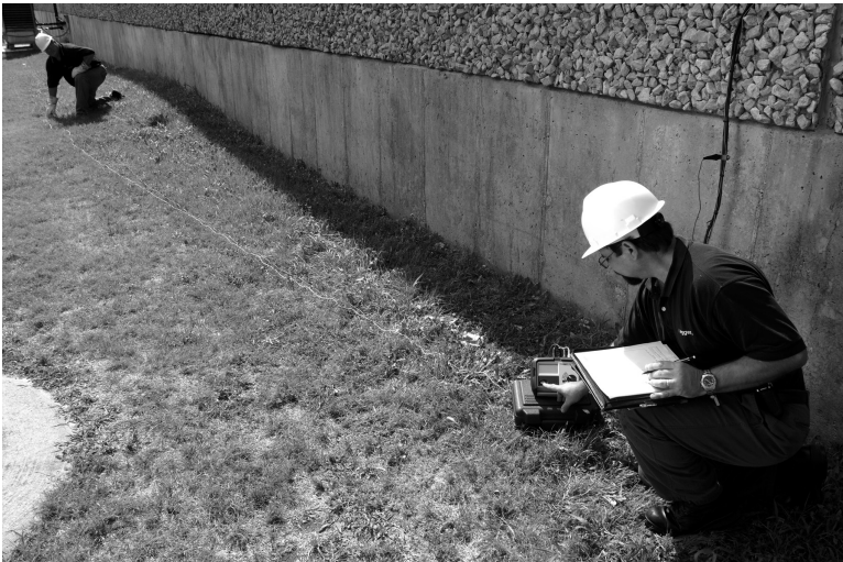
Verwendung eines Megger DET4-Geräts zur Prüfung der Gebäudeerdung
