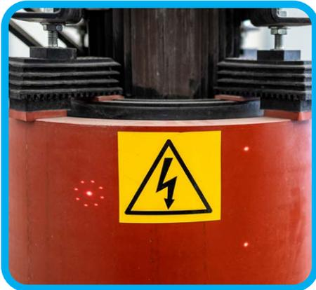
Der fortschrittliche Laserpointer bestimmt die Reichweite des Kreisfeldes vom gemessenen Bereich. Der DIT-120 bestimmt seine Reichweite mit zwei Laserpunkten. Der DIT-200 zeigt seinen Umfang mit einem Mehrpunkt laser an.
